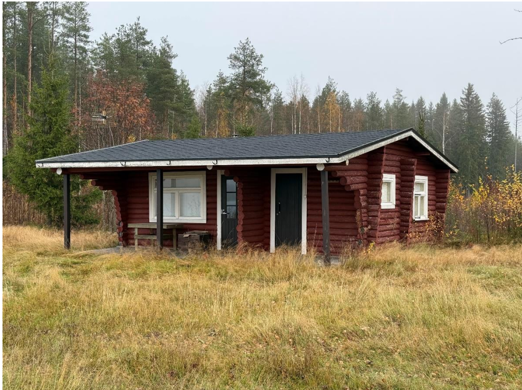
Mökissä sähkö- ja vesiliittymät, valmistunut 1970, 38 m 2 , matalaperusteinen mistä johtuen lattia kostea ja myydään purkukuntoisena
